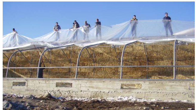
Լուսանկար 4. Պասիվ արևային ջերմատան կառուցումը Շիրակի մարզի Թորոսգյուղ գյուղում, 2016թ. նոյեմբեր
