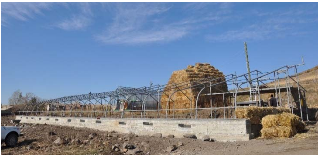
Լուսանկար 1. Պասիվ արևային ջերմատան կառուցումը Շիրակի մարզի Թորոսգյուղ գյուղում, 2016թ. նոյեմբեր
