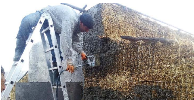
Լուսանկար 3. Պասիվ արևային ջերմատան կառուցումը Շիրակի մարզի Թորոսգյուղ գյուղում, 2016թ. նոյեմբեր
